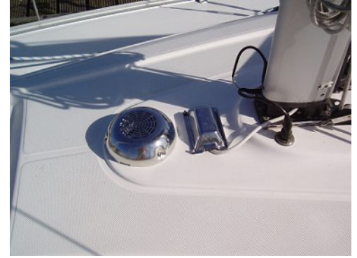
Für die Decksdurchführung des Kabels habe ich einen Cableport montiert.
