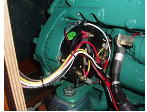
Die Leitungen des Sterlingreglers werden zusätzlich zu den bereits vorhandenen angeschlossen.
