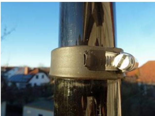
*Bild 1 Schlauchschele zur Sicherung eines Mastsegmentes wie im Text beschrieben.*
